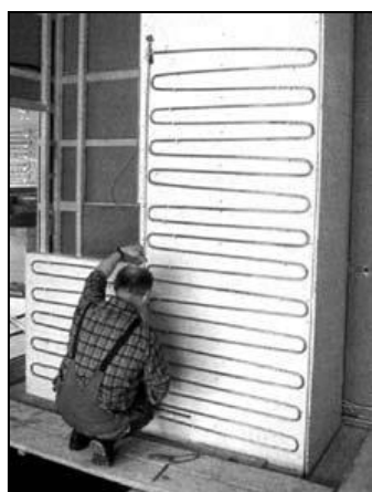
Figura 6-10: superfici radianti a parete
