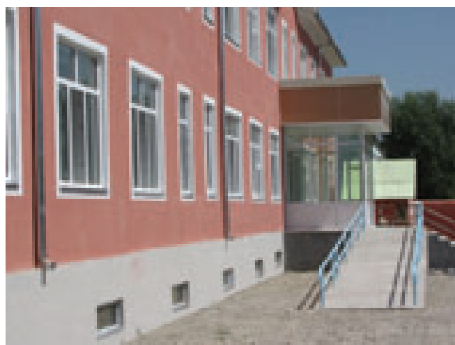
Фрагмент 7: Устройство пандуса
