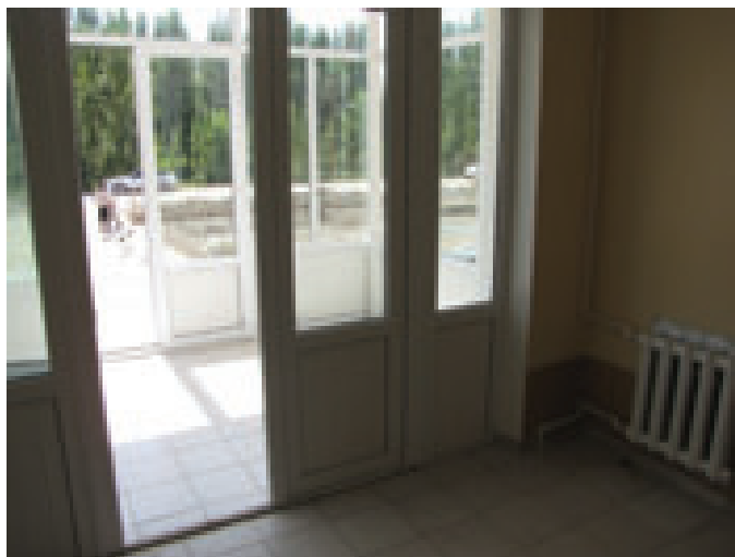
Фрагмент 4: Устройство входного тамбура из пластиковых рам и стеклопакетов
