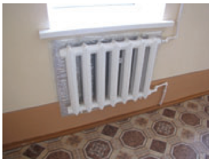
Фрагмент 5: Установка теплоотражающих экранов
