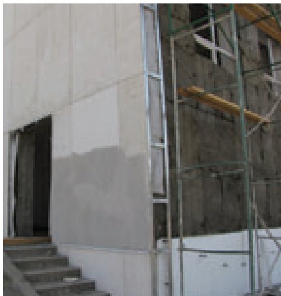
Фрагмент 2: «вентилируемый фасад»
