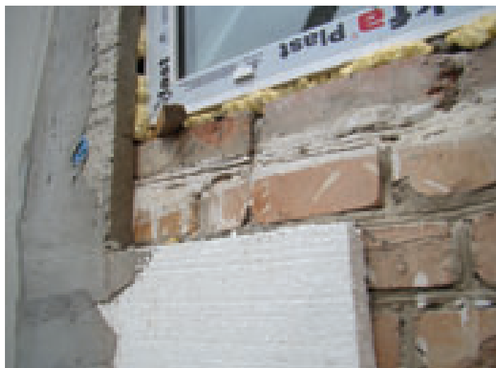
Фрагмент 1: Теплоизоляции стен
