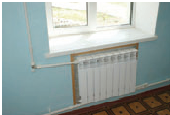
Фрагмент 6: Замена с труб системы отопления
