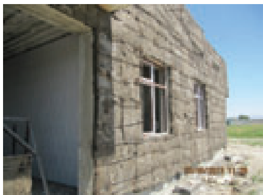
Наружная изоляция и фиксируемые арматурные сетки на здании туберкулезного санатория в Навоийской обл.
