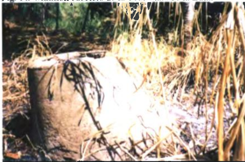
Fig. 14. Manholl obsoleto de la Urb. Valle de la Luna
