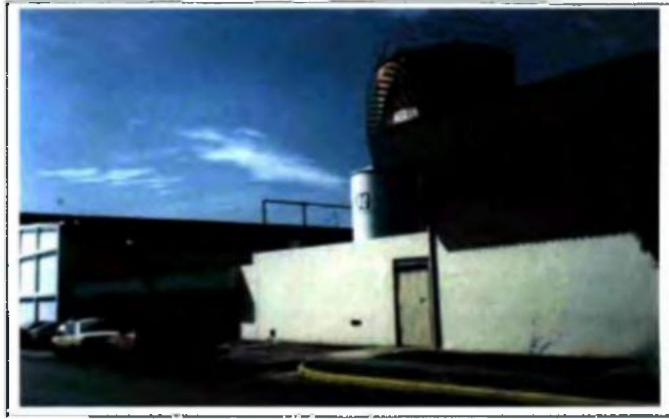
Figura .10. Instalaciones de la Empresa Coca Cola S.A.
