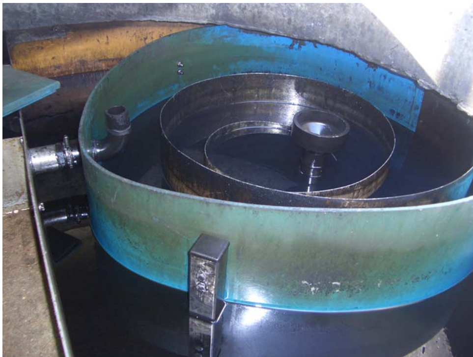
Figura 27: Interior de la planta de separació d'olis de sentina (Club Nàutic Estartit)
