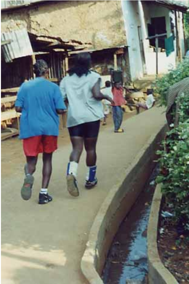
Ejemplo de micro-proyecto de infraestructura: pavimentación de una pista peatonal y construcción de la cuneta. Fuente: Magrinyà, 2001
