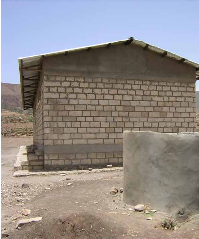
Captación de agua de lluvia en tejados. Fuente: ESF-INTERMON Etiopía (2003)
