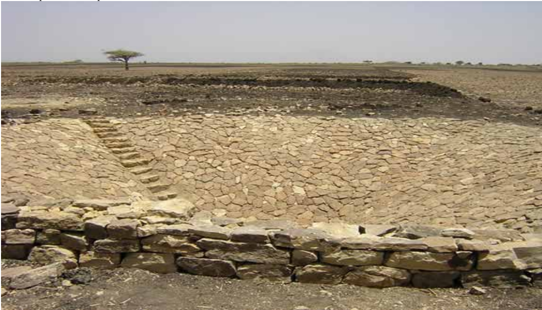
Tanque de almacenamiento de agua excavado en el terreno. Fuente: ESF-INTERMON Etiopía (2003)
