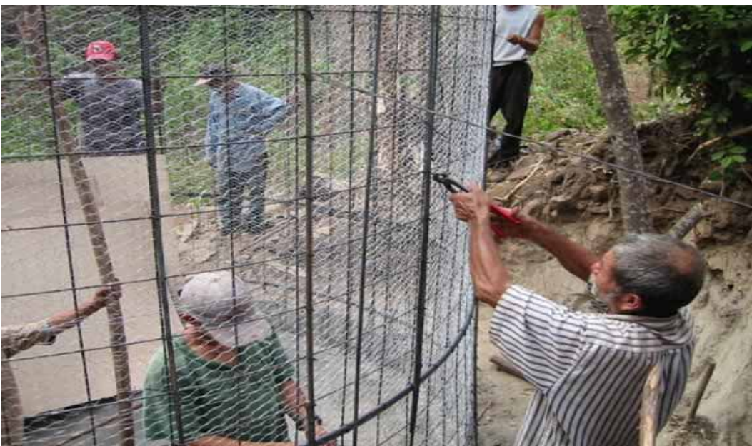
Proceso de atado de la malla en un tanque de ferrocemento. Fuente: ESF-El Salvador
