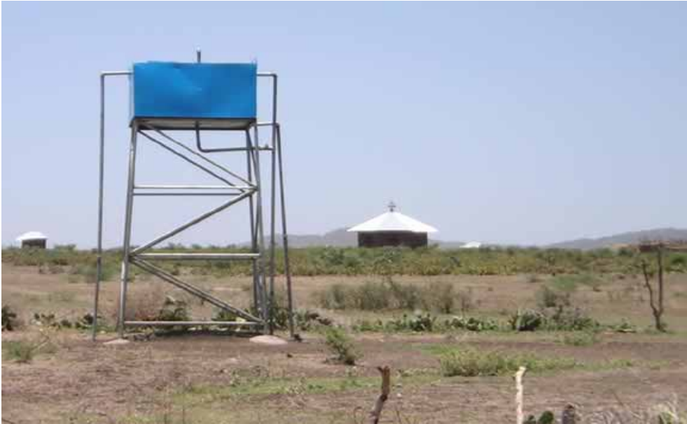
Los tanque elevados son una solución en zonas llanas.. Fuente: ESF-INTERMON Etiopia (2003)
