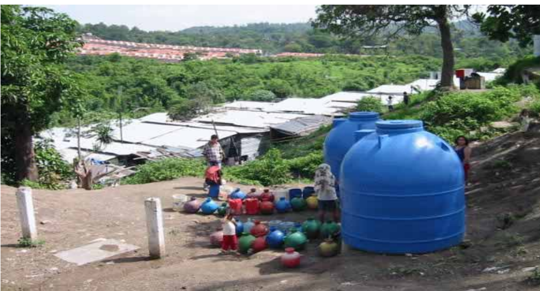
Tanque de almacenamiento de agua de lluvia de plástico. Fuente: ESF El Salvador (2002)
