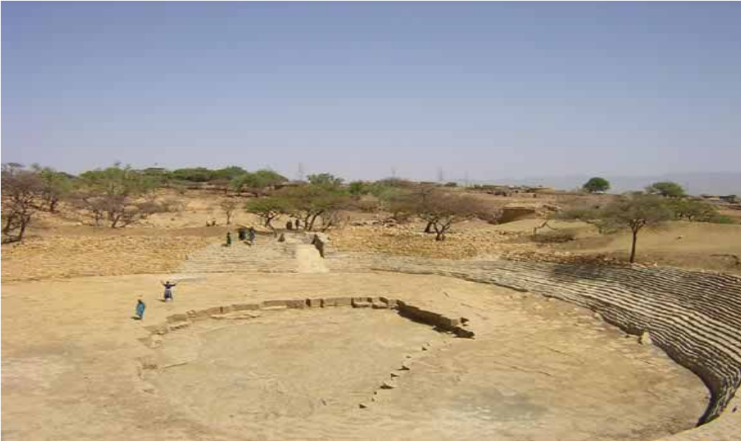
Tanque de almacenamiento de agua moldeado en el terreno. Fuente: ESF-INTERMON Etiopía (2003)
