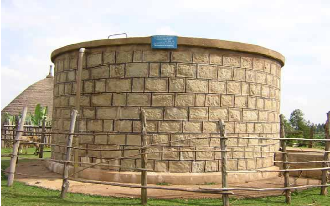
Tanque de mampostería de 100 m 3 . Fuente: ESF-INTERMON Etiopía (2003)
