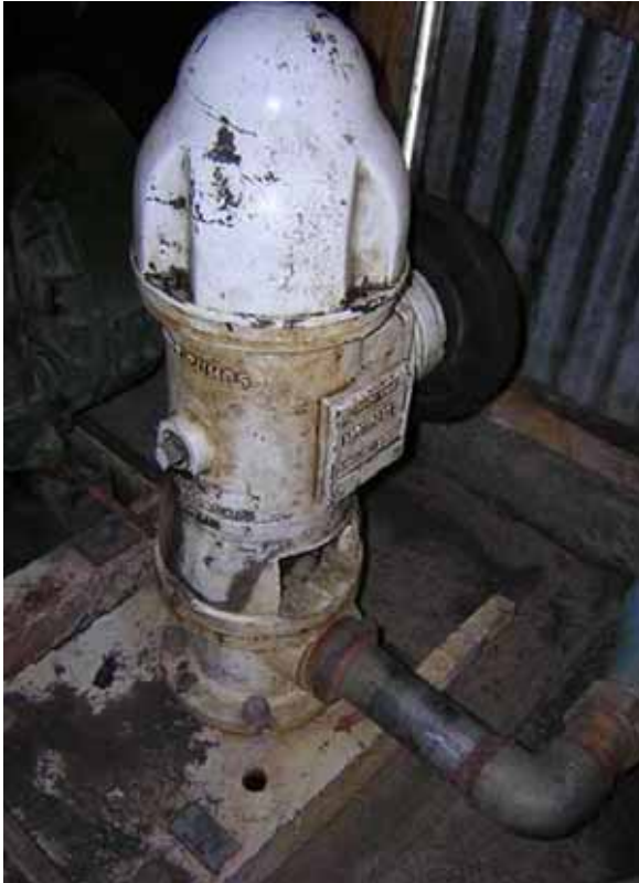
Bomba de rotor helicoidal (Tigray – Etiopía). Fuente: Manual de Criterios Técnicos para Proyectos de Agua en Etiopía. INTERMON - ESF
