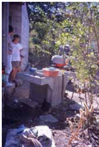
Conexión domiciliar y contador de agua. Fuente: ESF – El Salvador
