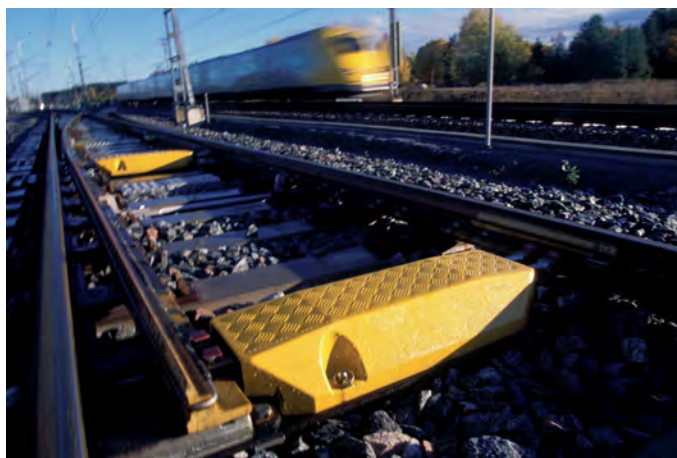
Rysunek 23: Widok napędu zwrotnicowego typu EbiSwitch 2000 (Bombardier) [24]
