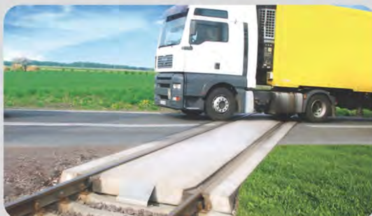
Rys. 4. Zabudowana płyta EDILON [3]
