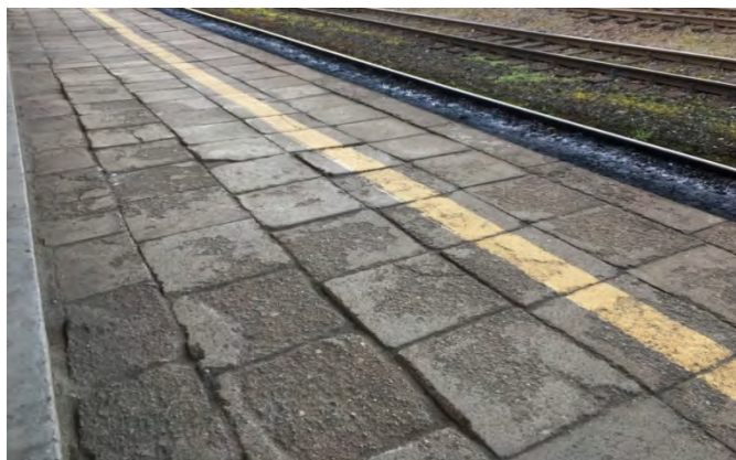
zdj.6 Nawierzchnia peronu 3 - Wejherowo
