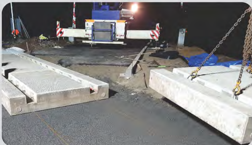
Rys. 4. Montaż płyt GTP na specjalnej podbudowie [mat. własne autora]
