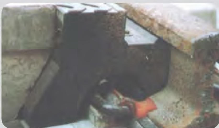
Rys. 6. Mocowanie gumowych elementów nawierzchni Holdfast [4]
