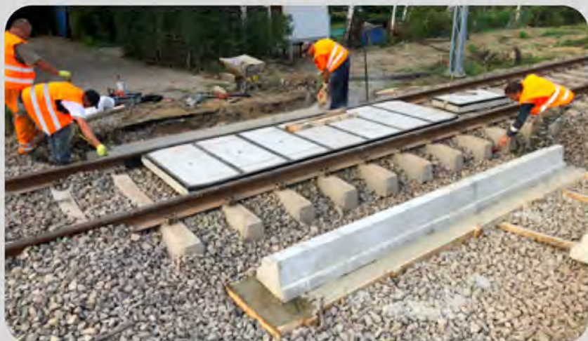
Rys. 2. Montaż płyt "Mirosław" - Warszawa Włochy [1]
