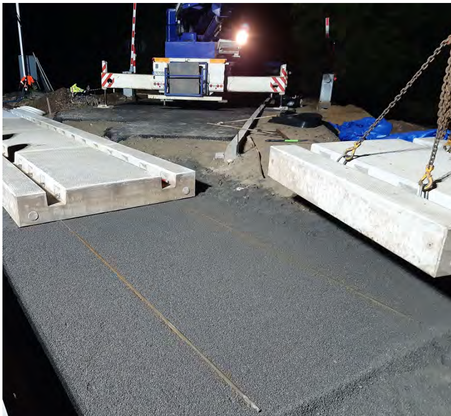
Rys. 6. Montaż płyt GTP na budowie [materiały własne autora]
