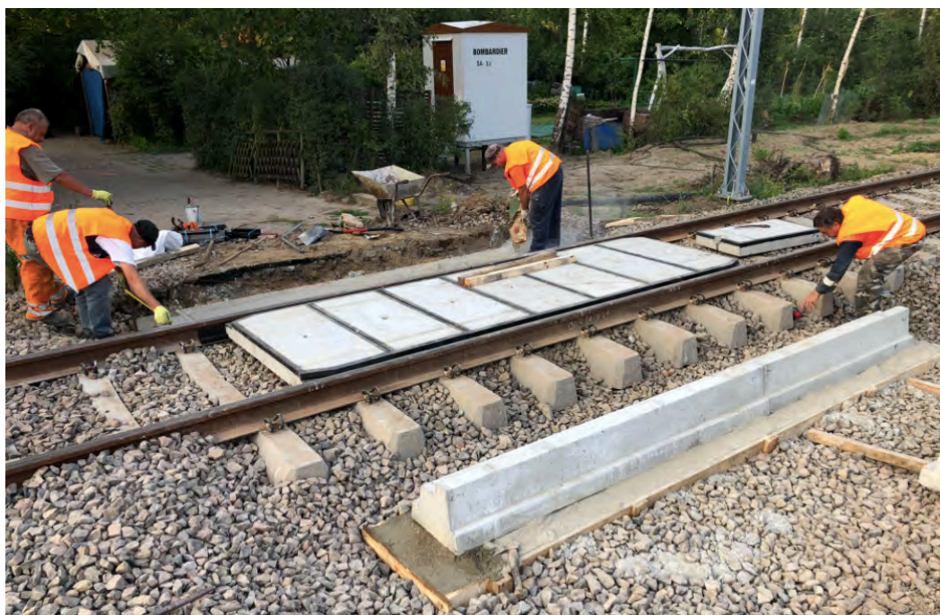
Rys. 3. Montaż nawierzchni typu Mirosław [3].
