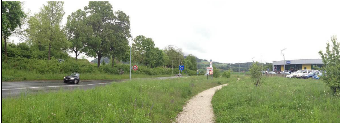
Strassenbegleitgrün, links die Bäume entlang der alten Bolligenstrasse, bestehende Bolligenstrasse, humusierte und begrünte Fläche zwischen Strasse und Fussweg
