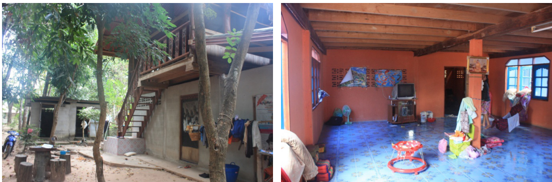
ภาพที่ 11 ใต้ถุนเรือน ส่วนใหญ่ของสมาชิกกลุ่มอินแปงในพื้นที่หมู่ 8 จะทำการปิดกั้นห้องบริเวณใต้ถุนในภายหลัง
