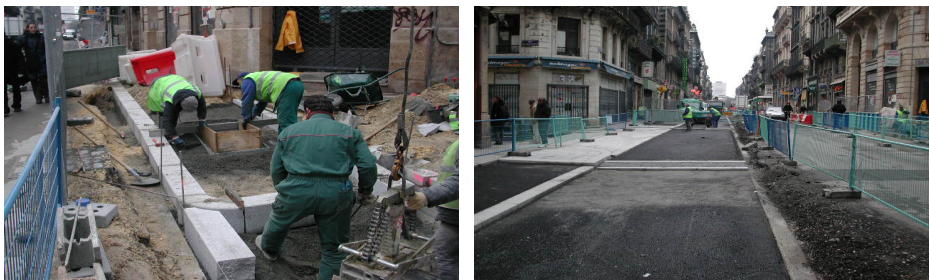
ภาพที่ 11 การปรับปรุงพื้นผิวสายทางด้วยวัสดุซีเมนต์เพื่อส่งน้ำผ่านลงระบบท่อแยก ก่อนวางรางของระบบราง ไฟฟ้า, เอกรินทร์ 2549
