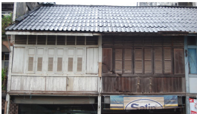
ภาพที่ 4 ประตู-หน้าต่างและช่องลมระบายอากาศที่เปิดตลอดช่วงเสา (Span) ภาพซ้าย การยื่นชายคา หรือหลังคา กั้นสาดเพื่อให้ร่มเงาและป้องกันละอองฝน
