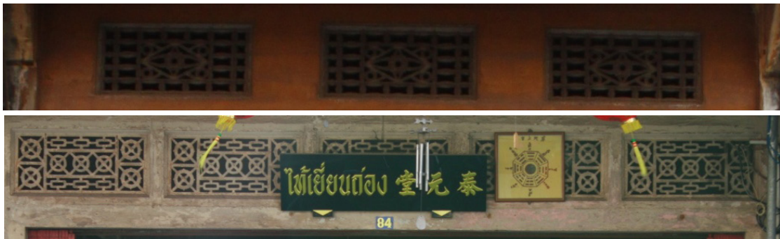
ภาพที่ 7 รูปแบบช่องแสงและช่องลมระบายอากาศ
