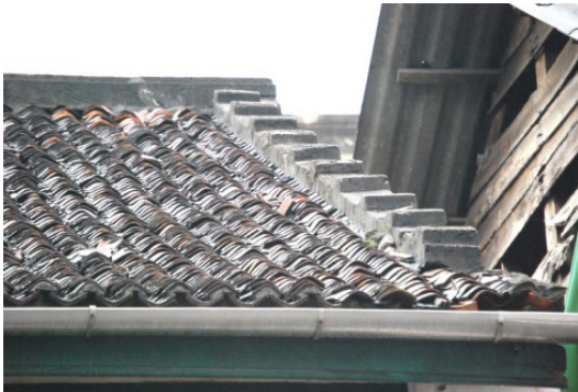
ภาพที่ 3 รูปทรงหลังคาจั่วที่มีความลาดชันมากและมุงด้วยวัสดุคงทนแข็งแรง
