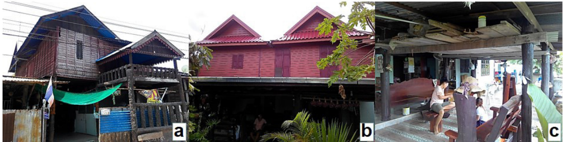
ภาพที่ 11 a การนำผ้าโบราณมาประกอบเป็นฝาเรือน b และ c ลักษณะการปรับปรุงเรือนหลังที่ 11 โดยใช้วัสดุใหม่เป็นส่วนประกอบของผนังและหลังคา รวมถึงการปรับปรุงพื้นที่ใช้สอยบริเวณใต้ถุน
