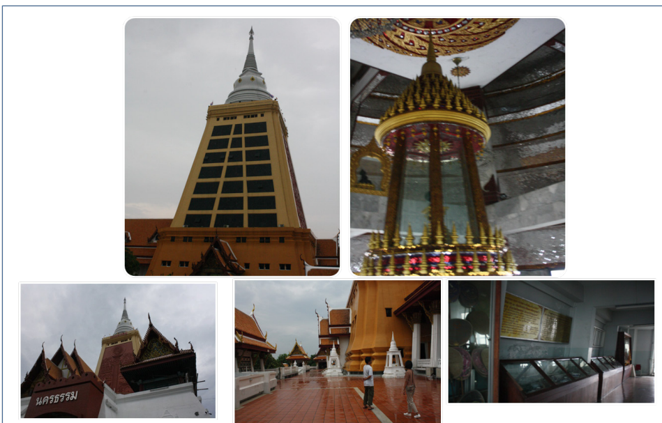
ภาพที่ 2 พระวิริยะมงคลมหาเจดีย์ศรีรัตนโกสินทร์ (บนซ้าย) ประดิษฐานพระบรมธาตุในชั้นสูงสุดของพระเจดีย์ (บนขวา) ส่วนด้านล่างเป็นลานประทักษิณ (ล่างกลาง) และพื้นที่ใช้สอยทั้งในและนอกอาคาร (ล่างซ้ายและขวา)
