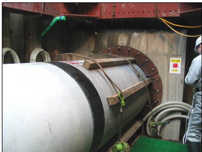
Obr.7 Protlačování betonového potrubí přes horninu, 4 m pod povrchem, do vzdálenosti 300 m. Foto autor
