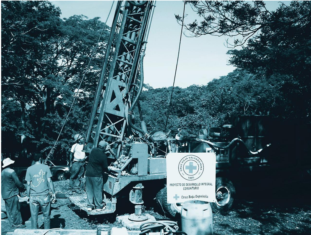
Ilustración 6 Perforación de Pozo en búsqueda de agua subterránea.
