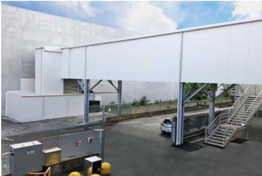
Figura 11 - Tunnel di collegamento al nuovo Centro Logistico di via Vernea
