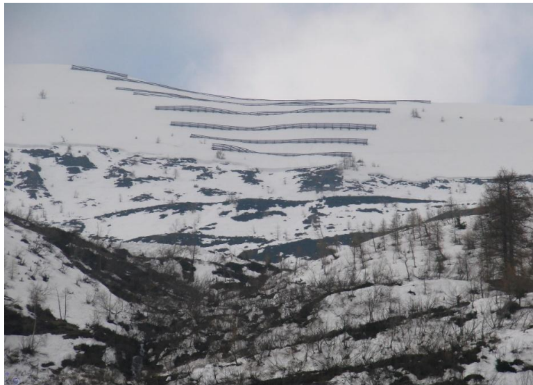
Figura 4.1-16: Valanga 18-030 - Evento del 05-05-2008, frattura nella zona di distacco a valle dei ponti da neve. Fonte (Catasto Valanghe Regionale SCT)
