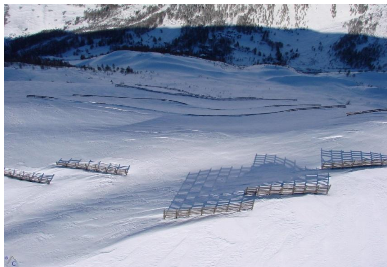
Figura 4.1-8: Valanga 18-030 - Elementi frangivento sulla cresta del Mont de La Saxe a monte dei ponti da neve in zona di distacco. Fonte (Catasto Valanghe Regionale SCT)
