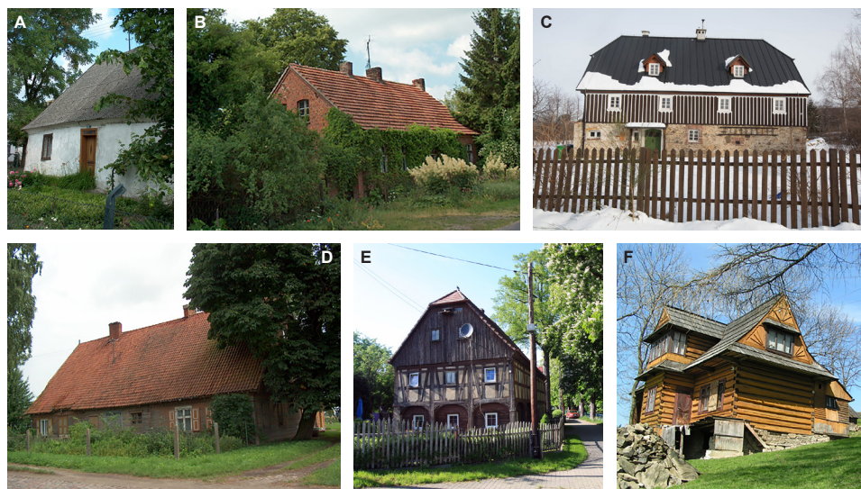
Ryc. 10. Przykłady domów mieszkalnych na wsi, charakterystyczne dla różnych regionów Polski: A – dom mieszkalny w konstrukcji drewnianej szkieletowej, tynkowany (Wielkopolska); B – dom murowany z cegły (Wielkopolska); C – dom w konstrukcji murowanej, łączonej ze szkieletową (Góry Izerskie); D – dom w konstrukcji zrębowej (Kujawy); E – dom przysłupowy (Dolne Łużyce); F – drewniany dom podhalański w konstrukcji zrębowej (fot. A. Wilkaniec)
