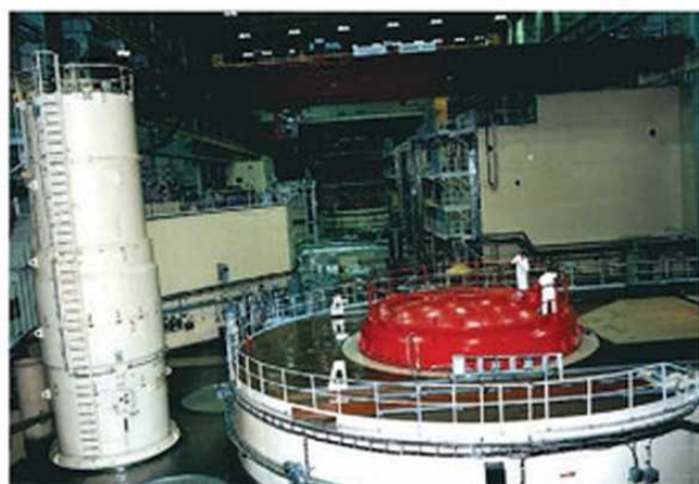
157.1. A reaktorblokkok csamoka a primer körön belül a paksi atomerőműben
