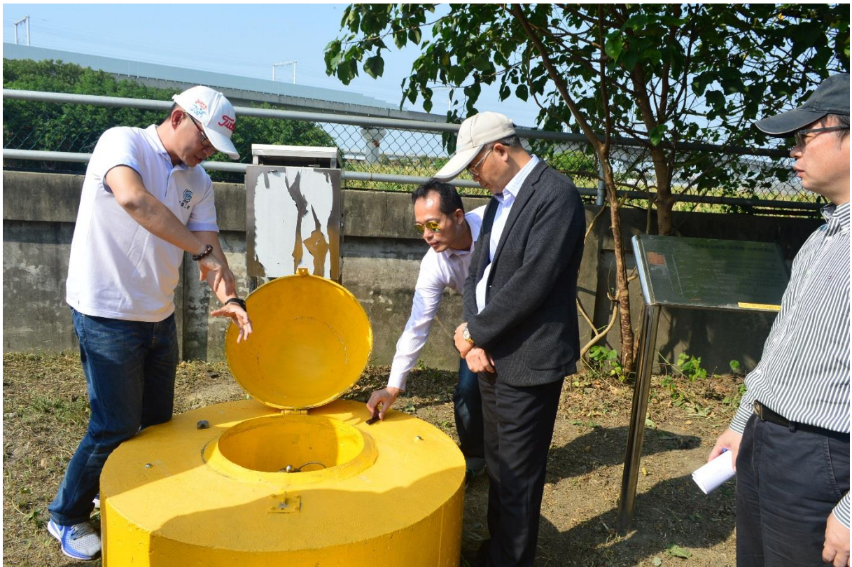
地層厚度變動量(深層水準樁)自動觀測站解說
