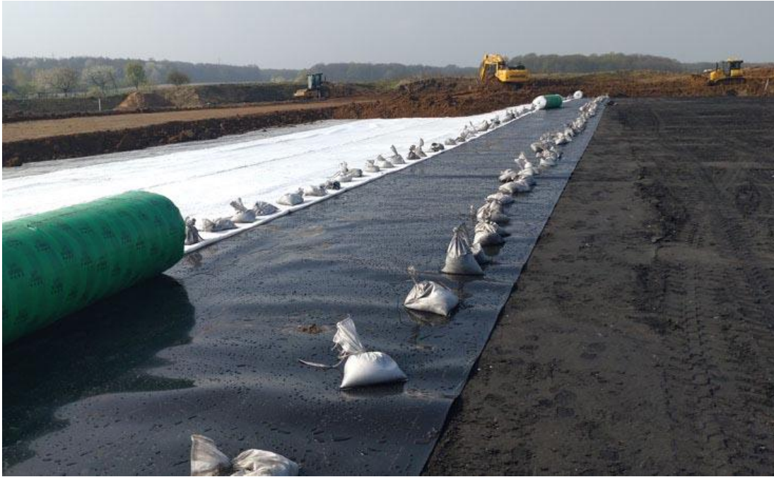
Abb. 43: Aufbringen der Kunststoffdichtungsbahn auf den Deponiekörper Viersen I
