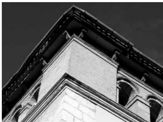
Figura 9. Remate de la cornisa del edificio
