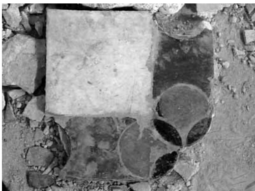
Figura 18. Fase de retirar el pavimento de figuras geométricas, evidenciando su precario estado de conservación
