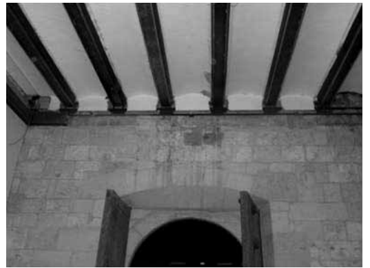
Figura 16. Vigas del suelo del salón noble, desde el vestíbulo, con el refuerzo realizado con anterioridad a esta intervención
