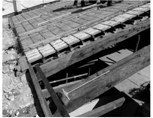
Figura 26. Reparación de faltantes en pares de madera Figura 27. Composición de la nueva cubierta
