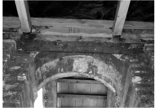
Figura 24. Apoyo de los pares de madera del tejadillo en el muro de cierre de patio original
