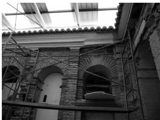
Figura 29. Trabajos de reposición de ladrillos y rejuntado en arcos
