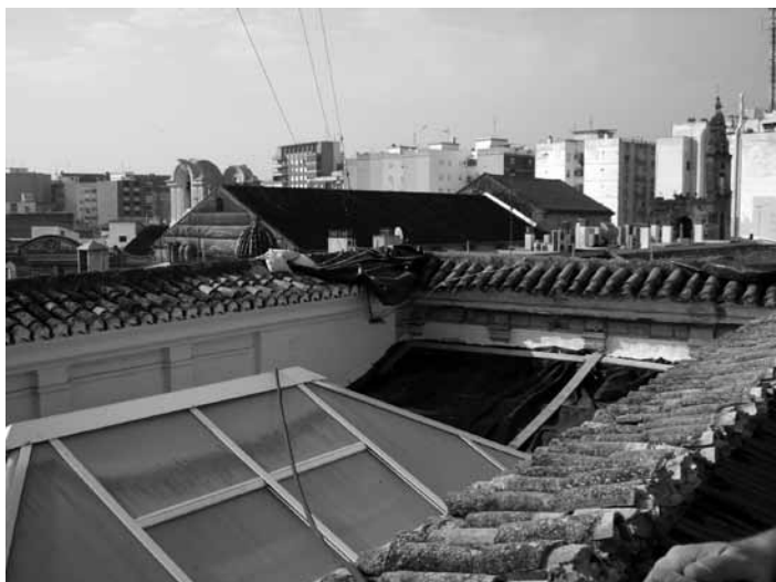
Figura 25. Tejadillo que cubría el lugar de paso a nivel de andana, delimitado por la cubierta a cuatro aguas de una intervención anterior.
