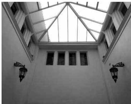
Figura 10. Fachada del patio interior, lado sur
