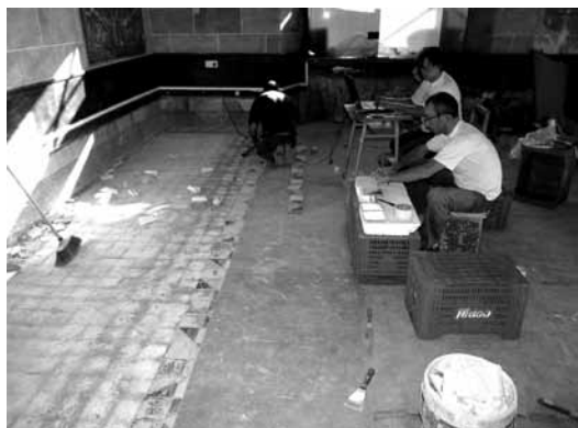
Figura 17. Fase de retirar el pavimento del siglo XVI y siglado del mismo para su consolidación y reposición posterior
