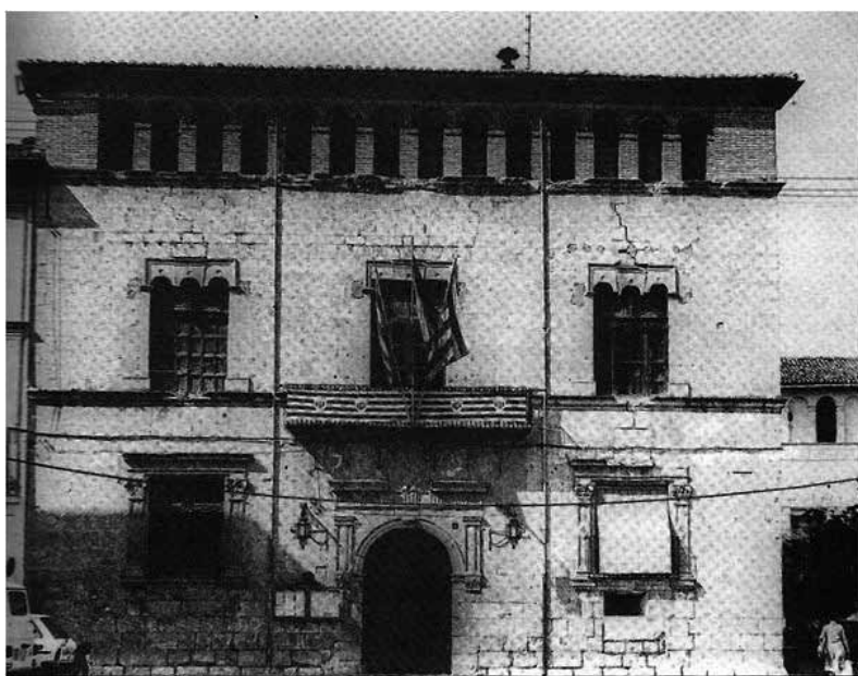
Figura 2. Fachada del Ayuntamiento, antes de su restauración de 1981
