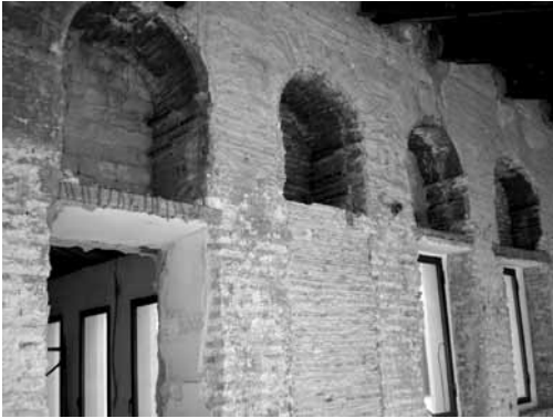
Figura 23. Pequeñas ventanas que se habían insertado dentro de los huecos en arco de este nivel
