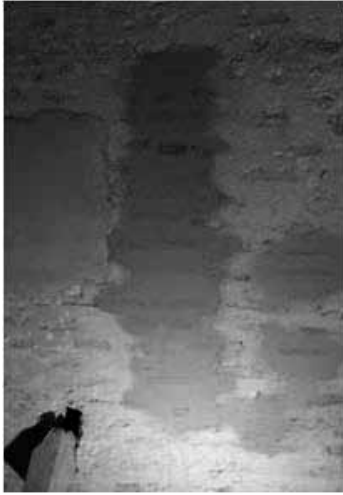
Figura 13. Reparaciones en el tapial Figura 14. Tacos de madera señalando el antiguo banco perimetral
