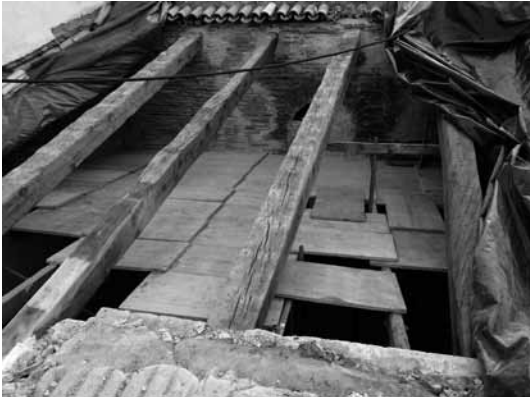
Figura 26. Reparación de faltantes en pares de madera Figura 27. Composición de la nueva cubierta
