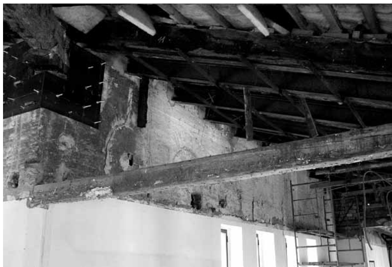
Figura 22. Aspecto de la andana, antes de la realización de los trabajos
