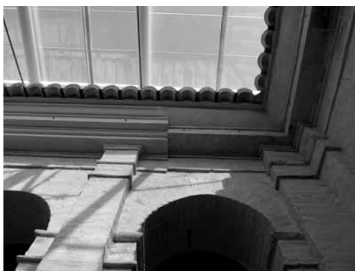
Figura 30. Detalle de la cornisa original en su encuentro con la cornisa de una reciente intervención
