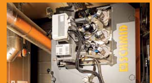
Versuchsanlage an der Hochschule Luzern mit Zonen-Vorschubrostfeuerungen und Elektroabscheider
