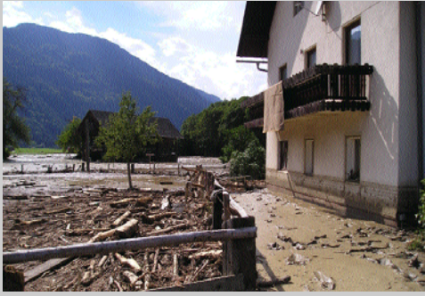
Hochwasserkatastrophe am 29. August 2003 in St. Stefan im Gailtal/Ortsteil Vorderberg.
