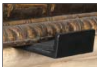
Une mousse isole le cadre de la patte de fixation.
