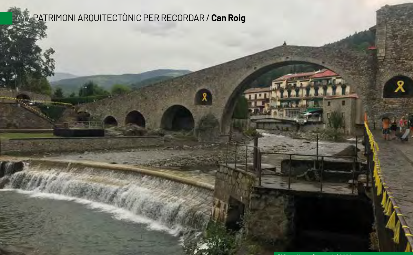
El Pont Nou a l'agost del 2020.
