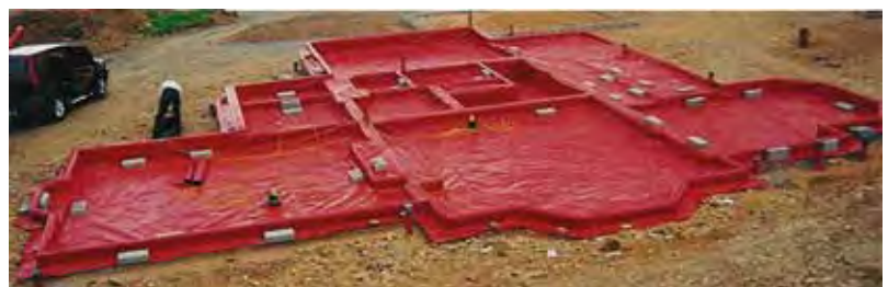
Protecció en obra nova amb làmina.
