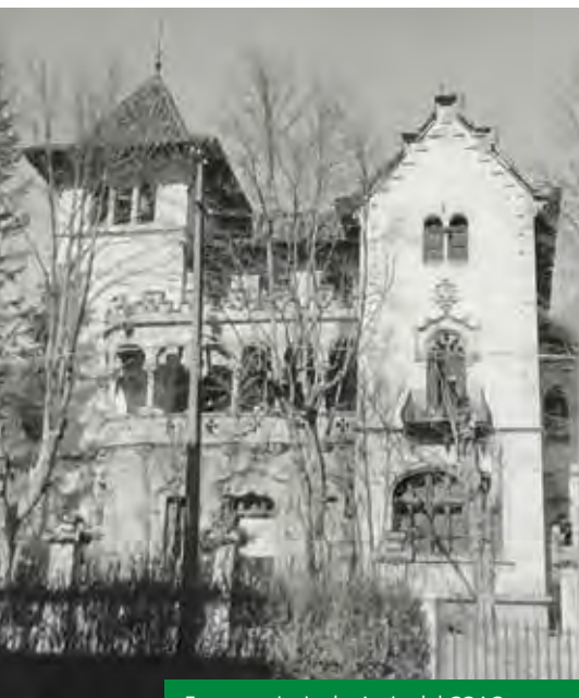
Façana principal – Arxiu del COAC.
