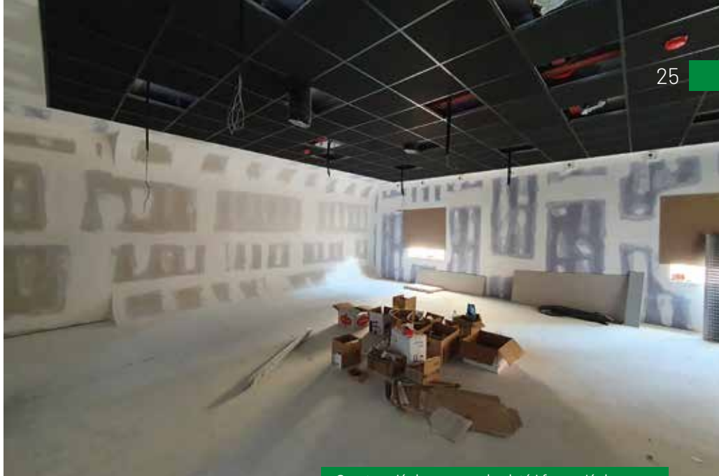
Construcció de a nova sala plató i formació de cromat.
