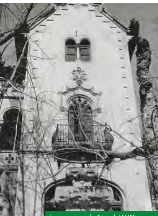
Façana principal – Arxiu del COAC.
