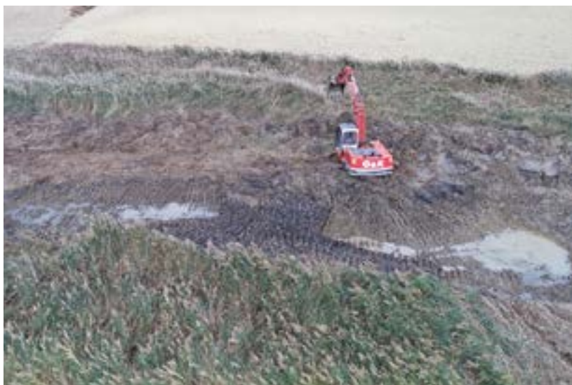
Construyendo con una retroexcavadora balsas en Bardenas Reales. I. GARIN-BARRIO
