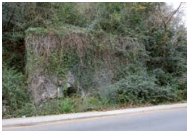
Vista del Horno calero de Latsuene (Donostia) antes del comienzo de los trabajos. A. MORAZA
