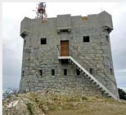
Vista del torreón después de su recuperación y puesta en valor. A la derecha, acceso al torreón, originalmente sólo disponía de una escalera de mano que por las noches se introducía al interior de la torre. © A. ORMAZA
