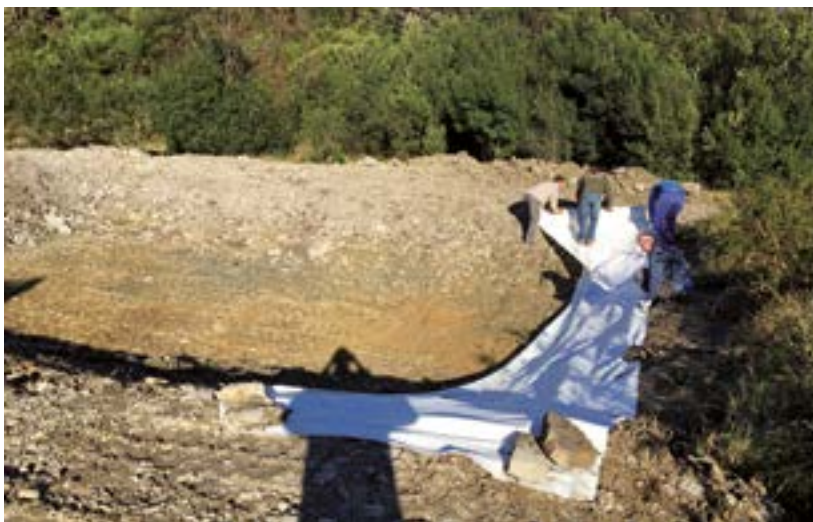
Langileak Zumaian sortu berri den putzua iragazgaizteko lanetan. © I. GARIN-BARRIO
