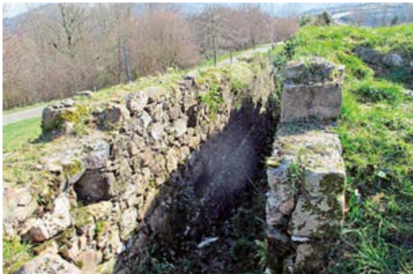
Detalle de una de las galerías aspilleradas del Fuerte de Arramendi (Errenteria) con las aspilleras para fusilería ). A. MORAZA
