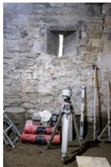
Detalle del vano abocinado registrado en el solar de Kale Nagusia nº 13 (Orío). © I. QUEVEDO
