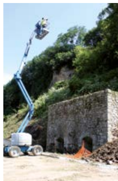
Proceso de registro fotogramétrico del Horno calero de Latsuene (Donostia).
