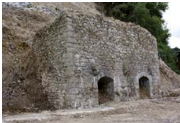
Vista del Horno calero de Latsuene (Donostia) a la finalización de los trabajos. A. MORAZA
