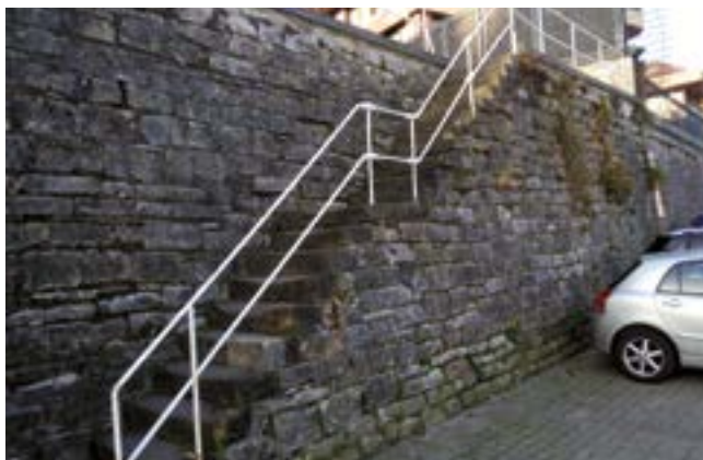
Figura 11. Escaleras entre el Paseo de Miraconcha y Paseo de Sanserreka.
