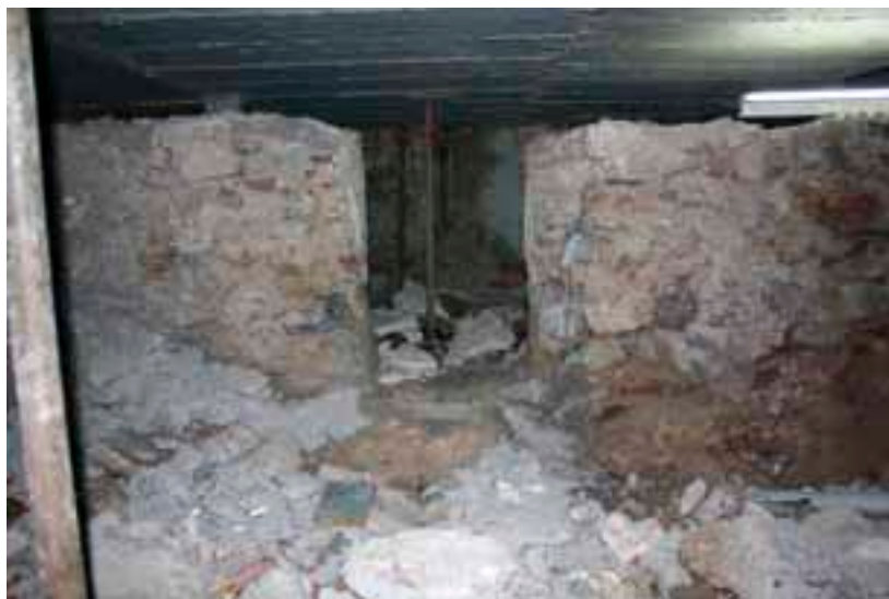
Vista del muro medianil documentado en la intervención en el solar de Fermin Calbeton 37.
