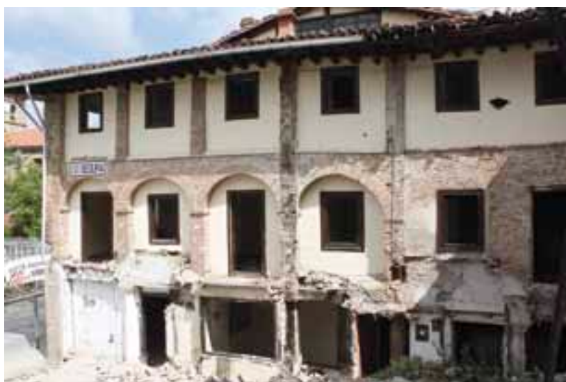
Levantamiento fotogramétrico de la fachada Sur del edificio de Kale Nagusia 27, con su galería porticada. M. GARCIA
