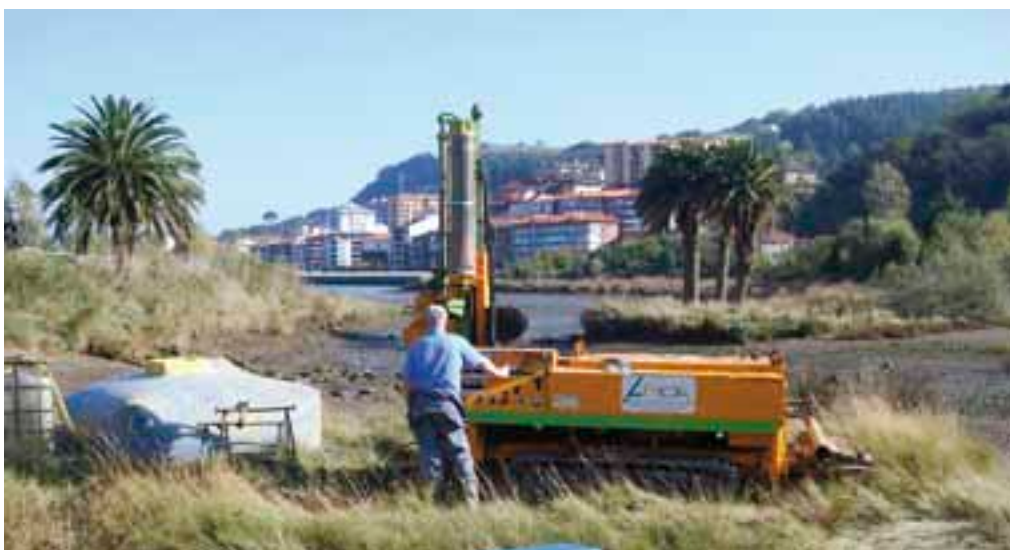
Perforación del sondeo en Deba (Geoparque de la Costa Vasca).
