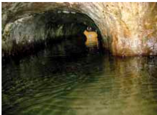
Galería inundada en la mina Elama.
