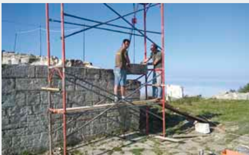
Trabajos de consolidación de la torre mayor. © J.AGIRRE
