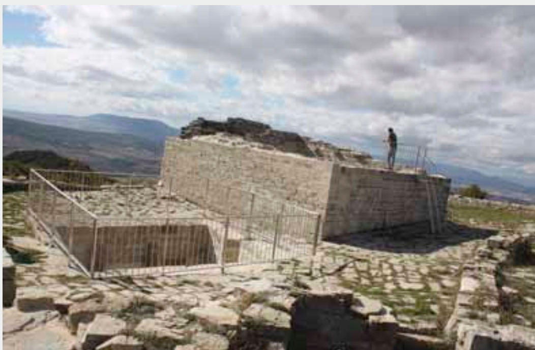
Castillo de Irulegi. Vista general tras la colocación de las barandillas y accesos.
