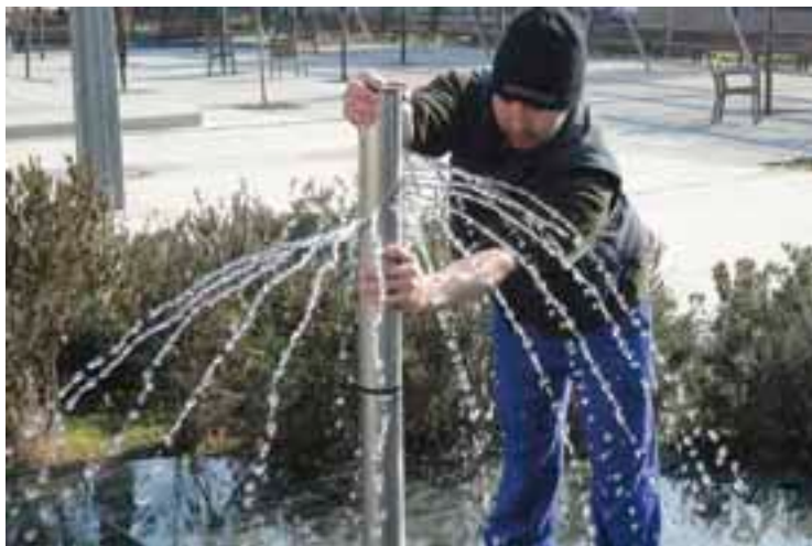
Iturri baten instalazio praktikak.
