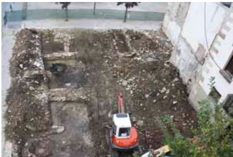
Perspectiva general del área de trabajo en el solar de Kale Nagusia 27. En la mitad izquierda las estructuras metalúrgicas. A. MORAZA
