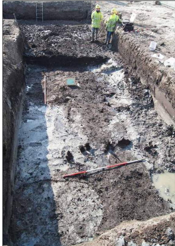
Afbeelding 47. Net boven de rood met witte jalon zijn de koppen van meerdere palen zichtbaar. Dit is de kopse kant van een jongere aanlegplaats. Werkput 1, foto richting zuiden.
