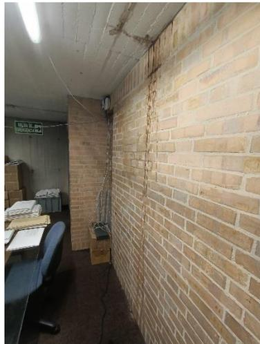
**Fotografía 101.** Existe una filtración de agua por la placa del techo del depósito que corresponde con el tercer piso. La filtración se produce desde la cubierta del edificio y está afectando dos niveles.
