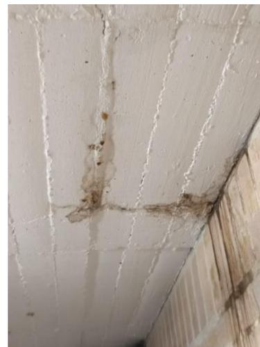
**Fotografía 102.** Detalle de la filtración en el techo y sobre la pared.
