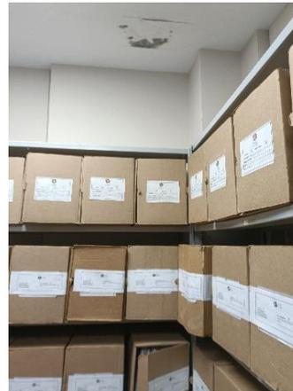
**Fotografía 54** En el techo se observa el lugar donde ocurrió la filtración de agua.
