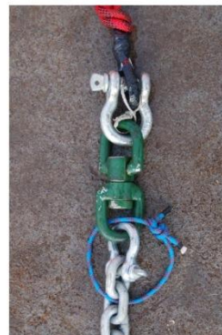
Dispositivo giratorio instalado en la base de los anclajes.
