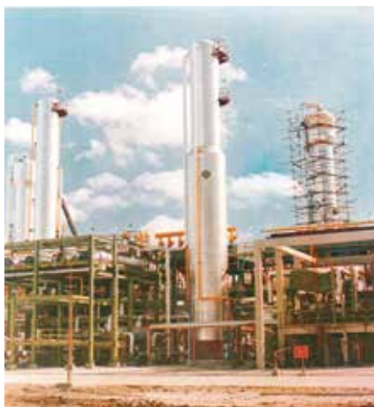
Torre deetanizadora, polo petroquímico de Bahía Blanca, 1981. Fuente: Boletín Techint n° 223 (julio-agosto-septiembre 1981)
