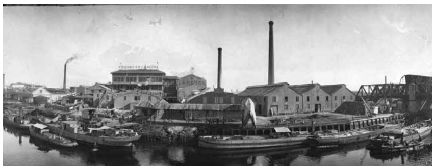
Frigorífico La Negra sin fecha. "[El frigorífico] La Negra [fue] fundado en 1885 por el francés Simón Gastón Sansinena sobre una antigua grasería en Avellaneda, con parte de capital local." Fuente: Archivo General de la Nación
