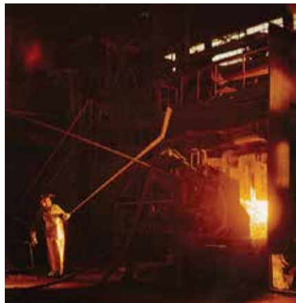
Horno eléctrico de ultra alta potencia, planta Siderca, 1988. Fuente: Boletín Techint n° 254 (septiembre-octubre 1988)
