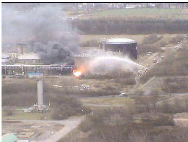
Figure 3 : accroissement de la flamme en direction de la vanne hydraulique et du by-pass. Tout semble indiquer que la flamme est alimentée par l'huile hydraulique du réservoir de la vanne.
