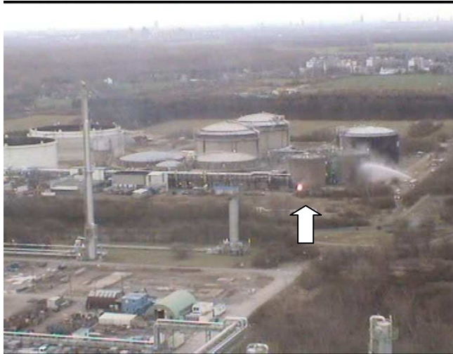
Figure 2 : flamme d'éthylène au niveau de la fuite sur le joint isolant (flèche) et refroidissement des réservoirs d'acrylonitrile par la brigade de pompiers.
