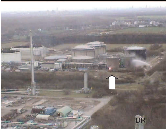
Figure 2 : flamme d'éthylène au niveau de la fuite sur le joint isolant (flèche) et refroidissement des réservoirs d'acrylonitrile par la brigade de pompiers.
