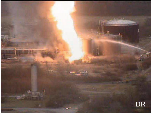
Figure 4 : flamme d'éthylène jaillissant du by-pass cassé de la vanne. Pression du gaz : 83 bars. Une demi-heure plus tard, le réservoir d'acrylonitrile prend feu à son tour.
