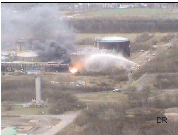
Figure 3 : accroissement de la flamme en direction de la vanne hydraulique et du by-pass. Tout semble indiquer que la flamme est alimentée par l'huile hydraulique du réservoir de la vanne.
