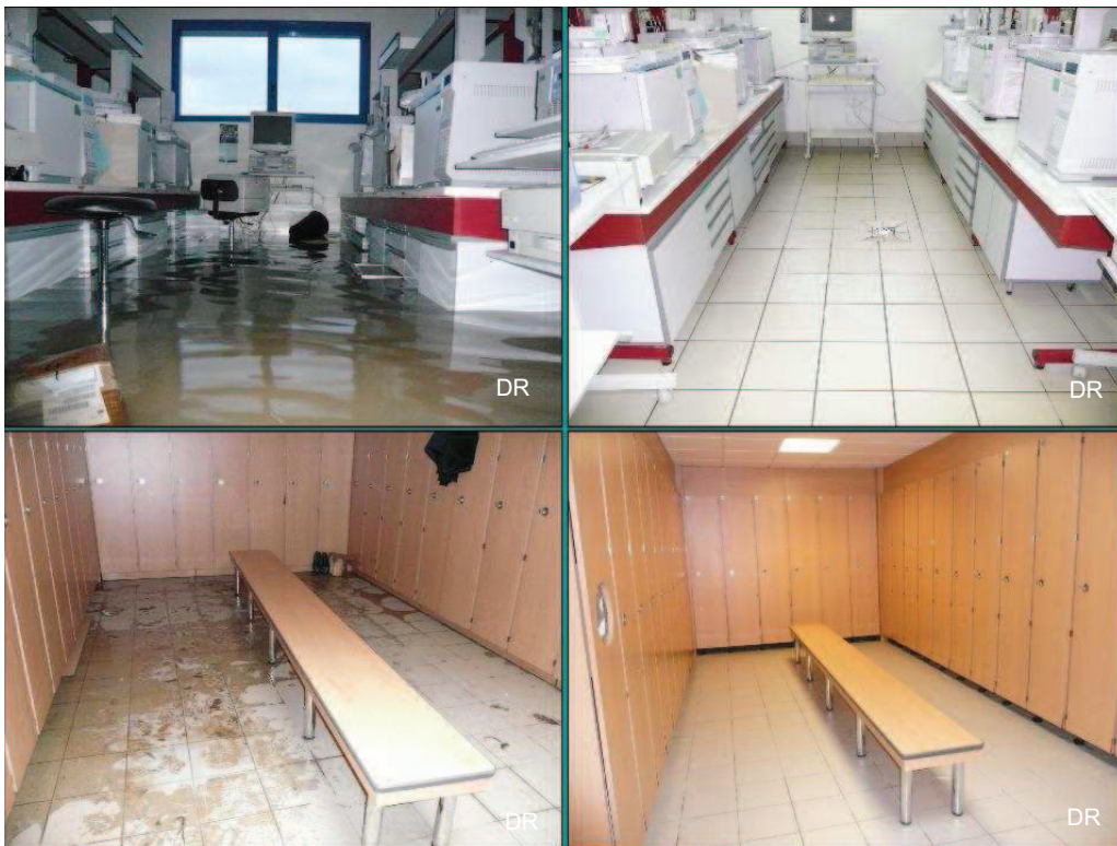
Remise en état rapide des installations (évacuation de l'eau, nettoyage, séchage, rangement)
