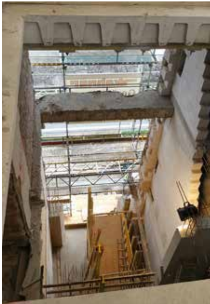
Fassadeneinschnitt für den Glaserker des neuen Treppenaufgangs
