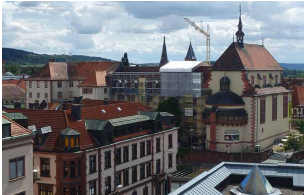
Der Gebäudekomplex während der Bauzeit
