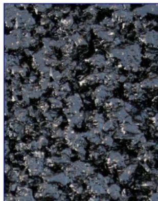
nach dem Einbau
