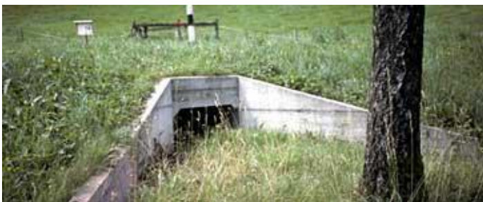
Fig. 2.5 Passaggio a norma per anfibi (foto: karch).
