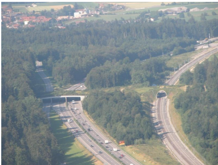
Fig. 2.3 Sovrappasso faunistico a norma presso Birchiwald (A1), in corrispondenza di un corridoio faunistico di importanza sovregionale: a sinistra 50 m sopra l'autostrada, a destra 25 m sopra il nuovo tratto a due binari delle FFS (foto: Amrein).
