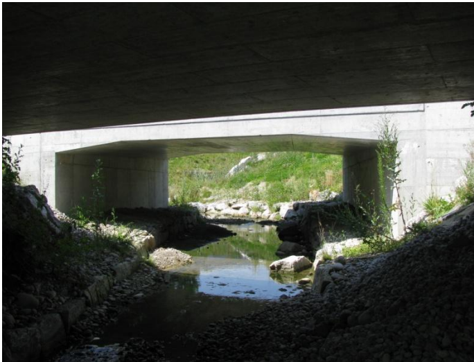
Fig. 2.1 Scatolare idraulico conforme alla norma VSS 640 696 [15].
