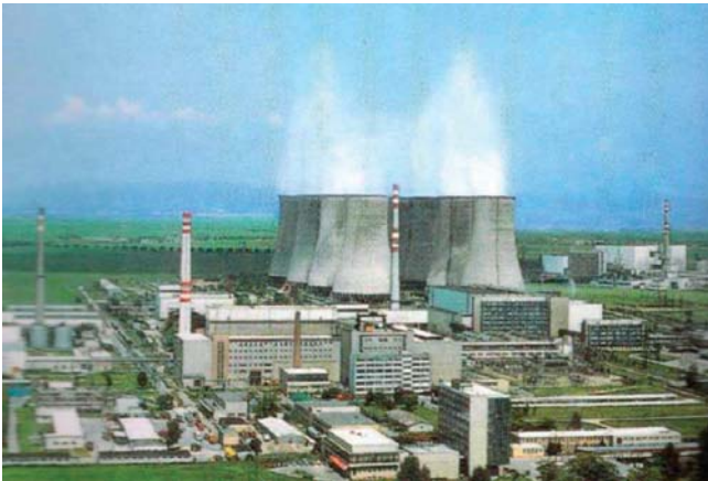
Obr.17 Celkový pohľad na Jadrovú elektrárňu Jaslovské Bohunice
