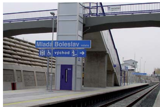
4 • REKONSTRUKCE STANIČNÍHO ZABEZPEČOVACÍHO ZAŘÍZENÍ V ŽST. MLADÁ BOLESLAV-DEBŘ
