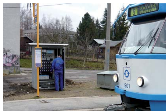
5 • NOVÉ ZABEZPEČOVACÍ ZAŘÍZENÍ NA TRAMVAJOVÉ JEDNOKOLEJCE VE VŘESINĚ
