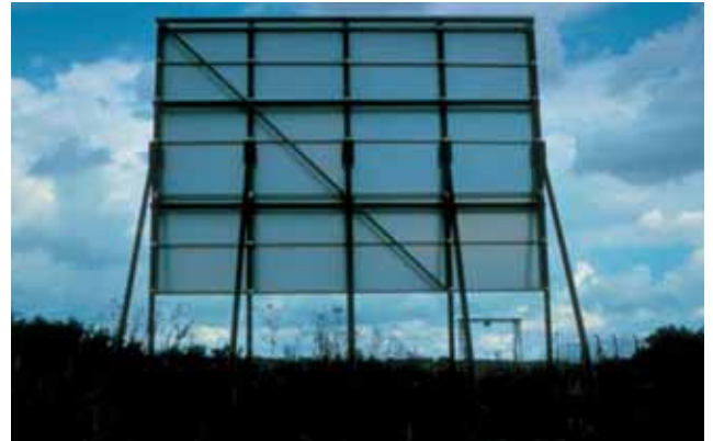
Při výrobě velkých panelových tabulí jsou hliníkové desky spojitě lepeny podél výztuží. Pnutí je tak rovnoměrně rozloženo, takže spoj bude mít vysokou nosnost, bez deformací.
