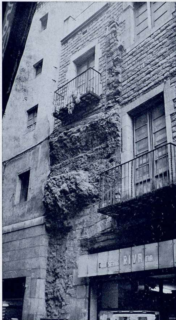
Fig. 20. Aspecte de les muralles en el carrer del Call, on sembla que s'entreveu la imposta d'un marc pertanyent, potser, a la porta sud, en la seva sistematització tardo-imperial (foto A. Rovira)
