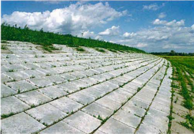
Abb. 3: Beginnende Begrünung eines Deckwerks ca. ein Jahr nach Verlegung (Quelle: Berding-Beton GmbH)
