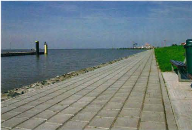
Abb. 2: Deckwerk aus verzahnten Setzsteinen (Quelle: Berding-Beton GmbH)
