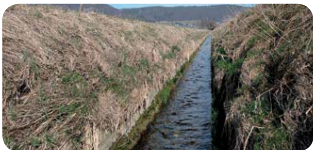
Avant la remise en valeur des berges: les murets de renforcement en béton sont des obstacles pour les petits animaux.
