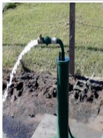
Fig. 1 Saída de água de um furo
