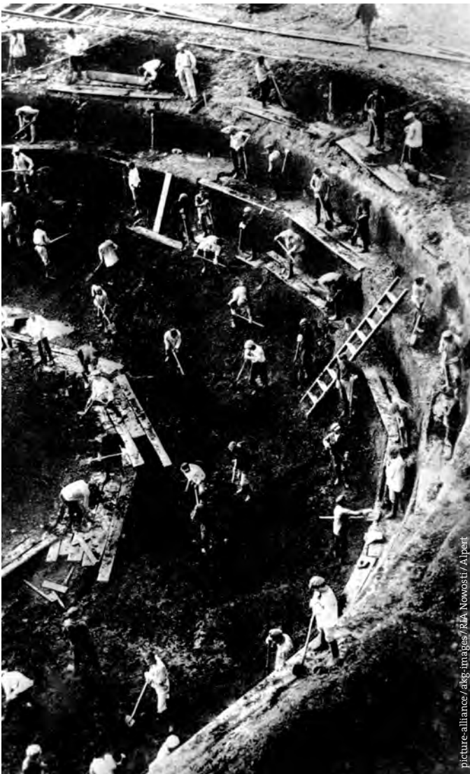
Ebenfalls Teil des Fünfjahrplans ist der Bau von Stahl- und Wasserkraftwerken. Bauarbeiter beim Ausschachten einer Grube für das Fundament eines Hochofens der Eisen- und Stahlwerke in Magnitogorsk 1930 (li.) und Herstellung einer Turbine in den Elektrosila-Werken in Leningrad für ein Wasserkraftwerk am Dnjepr, 1932
