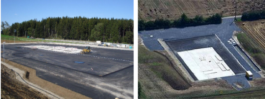
Abb. 6.9: Bohrplätze mit Fundament für den Bohrturm (Geothermische Kraftwerksgesellschaft Traunreut mbH 2012, ExxonMobil Production Deutschland GmbH 2011a)
