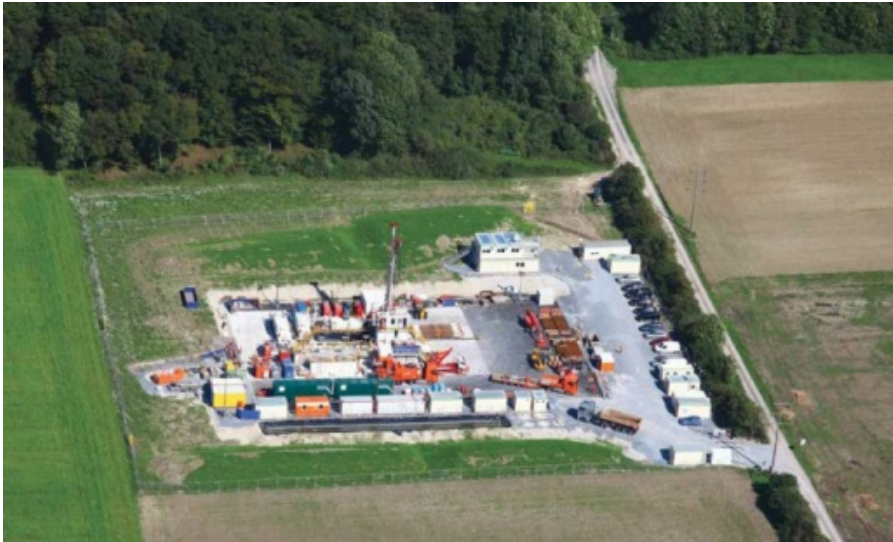
Abb. 6.7: Bohrplatz mit Nebeneinrichtungen (Schneble et al. 2011)
