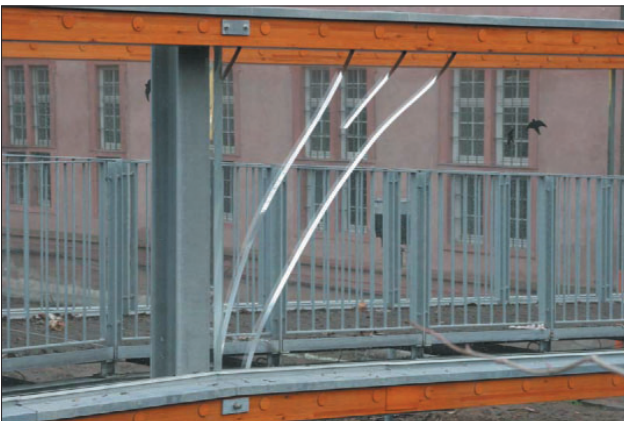
Abb. 10: Risse im PMMA nach heftigem Temperatursturz
