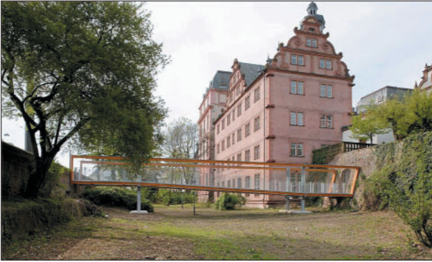
Abb. 9: Realisierte Brücke über den Schlossgraben in Darmstadt
