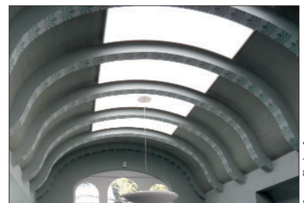
Abb. 14: Verstärkung eines Tonnengewölbes; links: schadhaftes Gewölbe vor der Sanierung; Mitte: Einbetten des Carbonegeleges in die Feinbetonschicht; rechts: Tonnenschale nach der Instandsetzung
