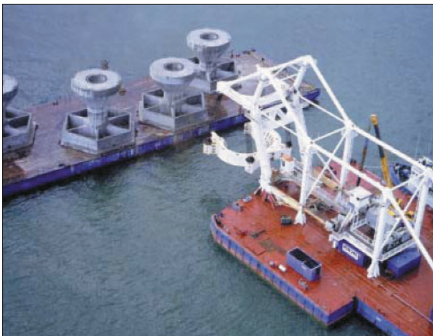
Abb. 19: Herstellung der Gründungskörper auf einem Schwimmponton
