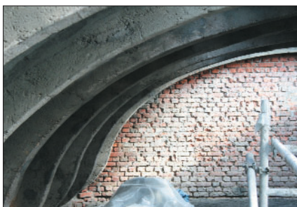
Abb. 14: Verstärkung eines Tonnengewölbes; links: schadhaftes Gewölbe vor der Sanierung; Mitte: Einbetten des Carbonegeleges in die Feinbetonschicht; rechts: Tonnenschale nach der Instandsetzung
