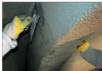
Abb. 14: Verstärkung eines Tonnengewölbes; links: schadhaftes Gewölbe vor der Sanierung; Mitte: Einbetten des Carbonegeleges in die Feinbetonschicht; rechts: Tonnenschale nach der Instandsetzung
