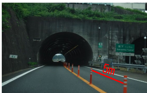
【ポストコーン設置状況（昼間）】
