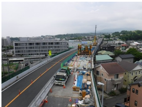
【床版取替工事 全景】
