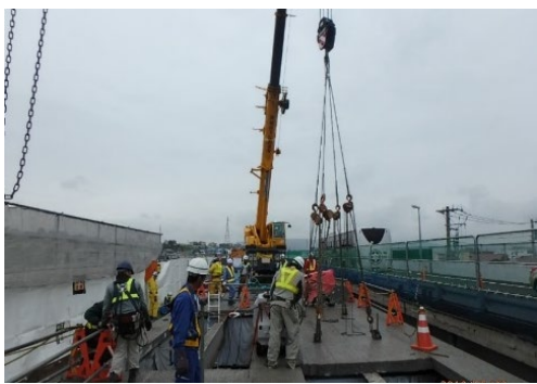
【老朽化した床版の撤去】
