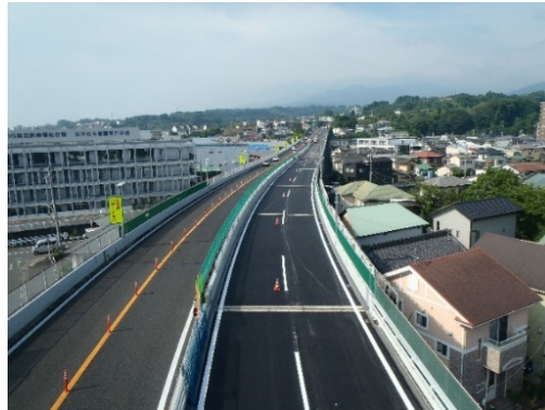
【床版取替完了後】
