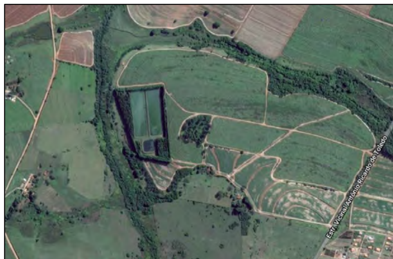
Figura 17 – Foto aérea da Estação de Tratamento de Tabapuã.
