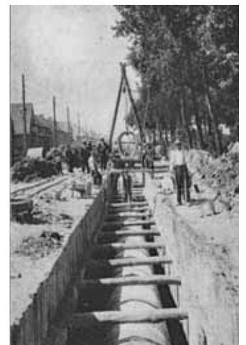
Aanleg riolering Halvenmaanstraat in 1930. EIB 26811
