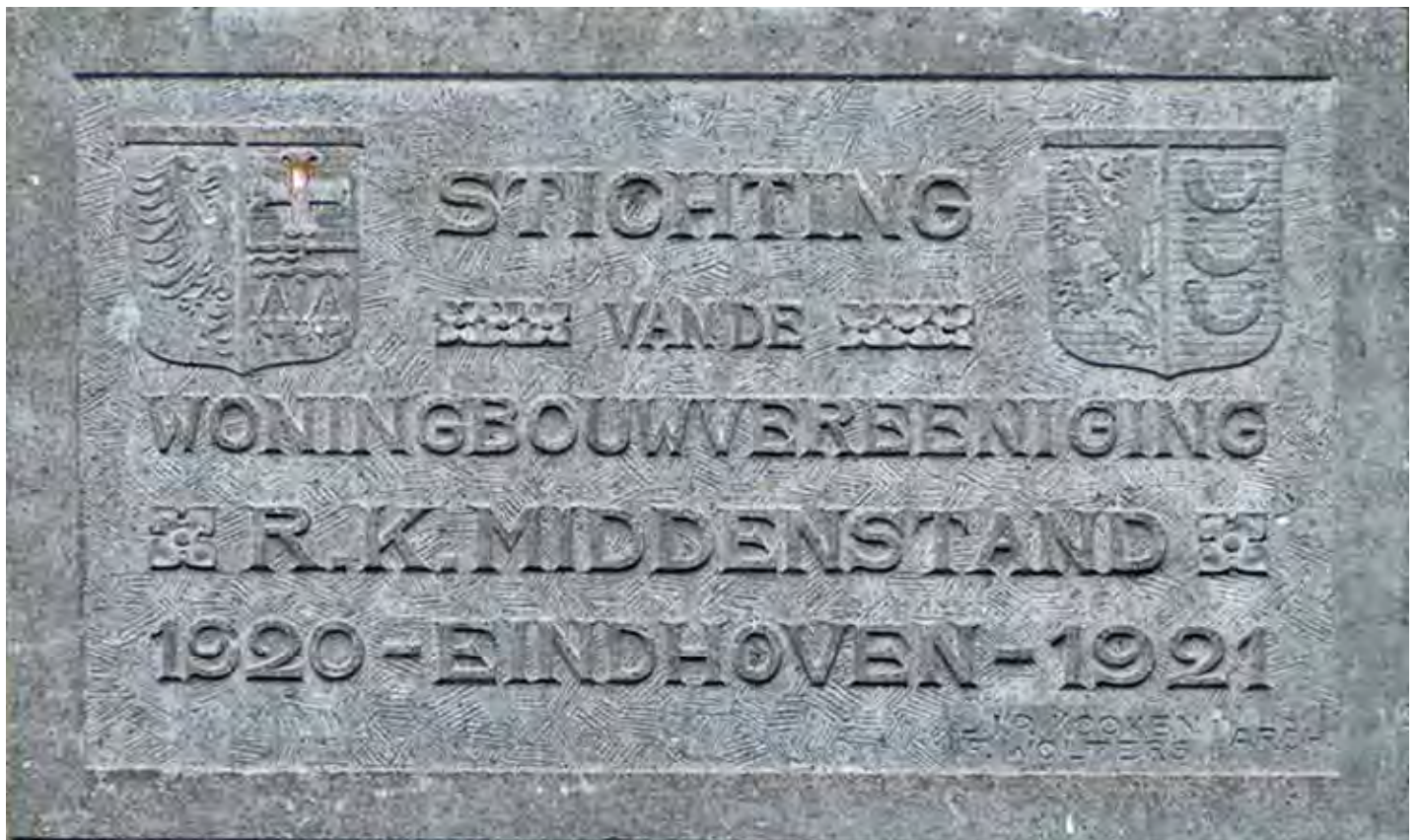
De gevelsteen van de Woningbouwvereniging R.K. Middenstand in de Pauwlaan. Architecten Louis Kookken en Frans Wolters. EIB 11961
