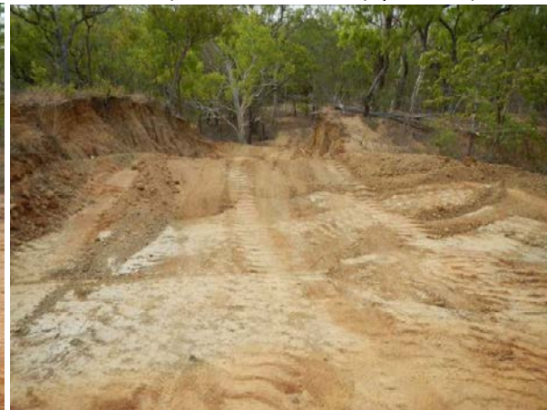
f) After Construction (Jan-2012)
