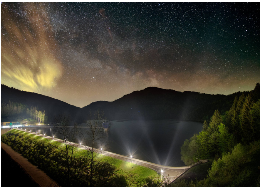
Svitidla na hrázi přehrady Šance po jejich instalaci. Foto: Jan Kondziolka
