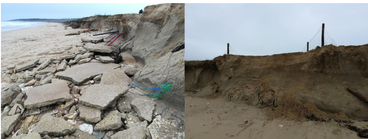
Figure 36 : Sévère érosion entre Grand-Village et l'Ecuisière en 2019 – source : CPIE MO
