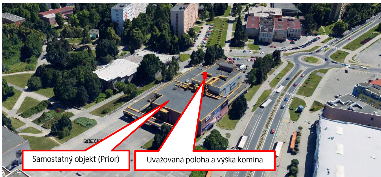
Obrázek 5 - Samostatná kotelna v samostatném objektu
