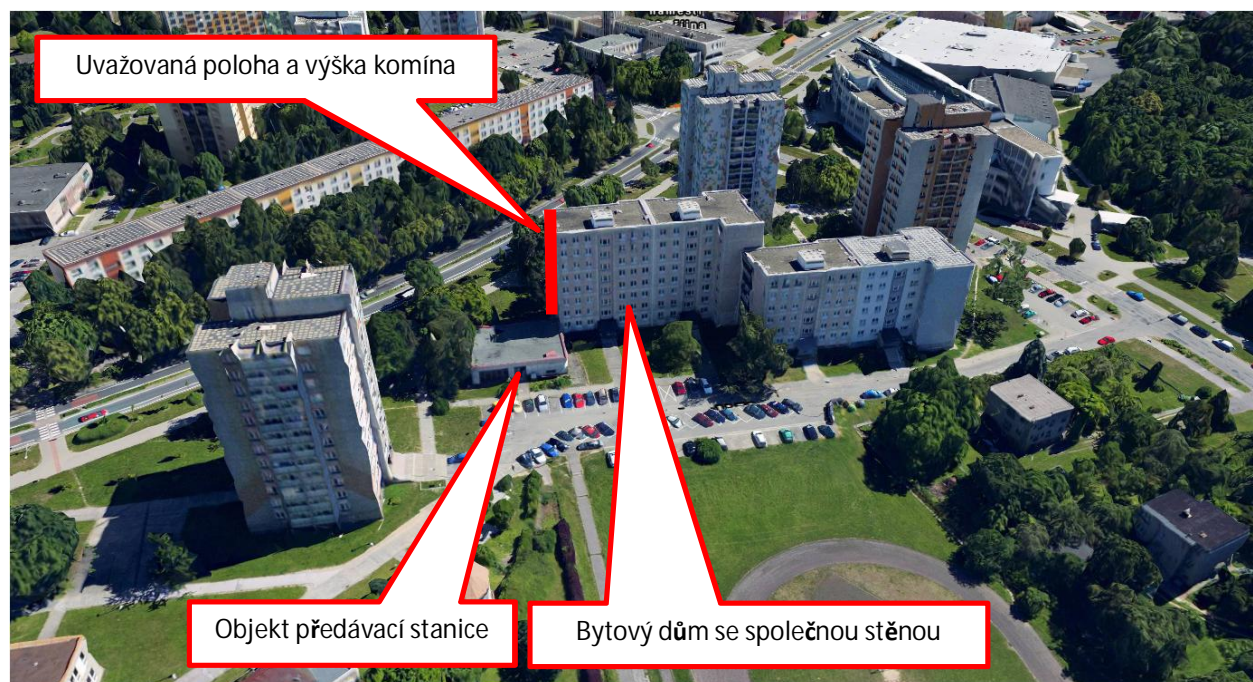
Obrázek 3 - Předávací stanice (kotelna) se společnou stěnou s vyšším bytovým domem
