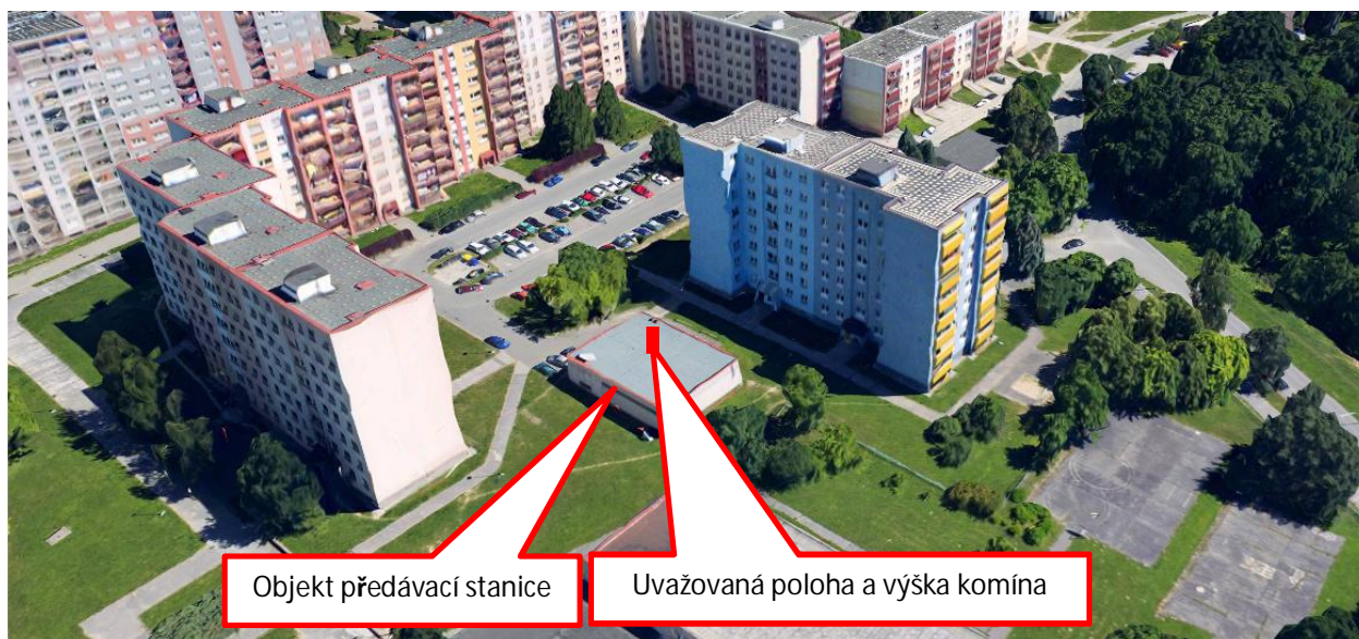
Obrázek 4 - Samostatná předávací stanice (kotelna) uprostřed obytné zástavby s vyššími domy
